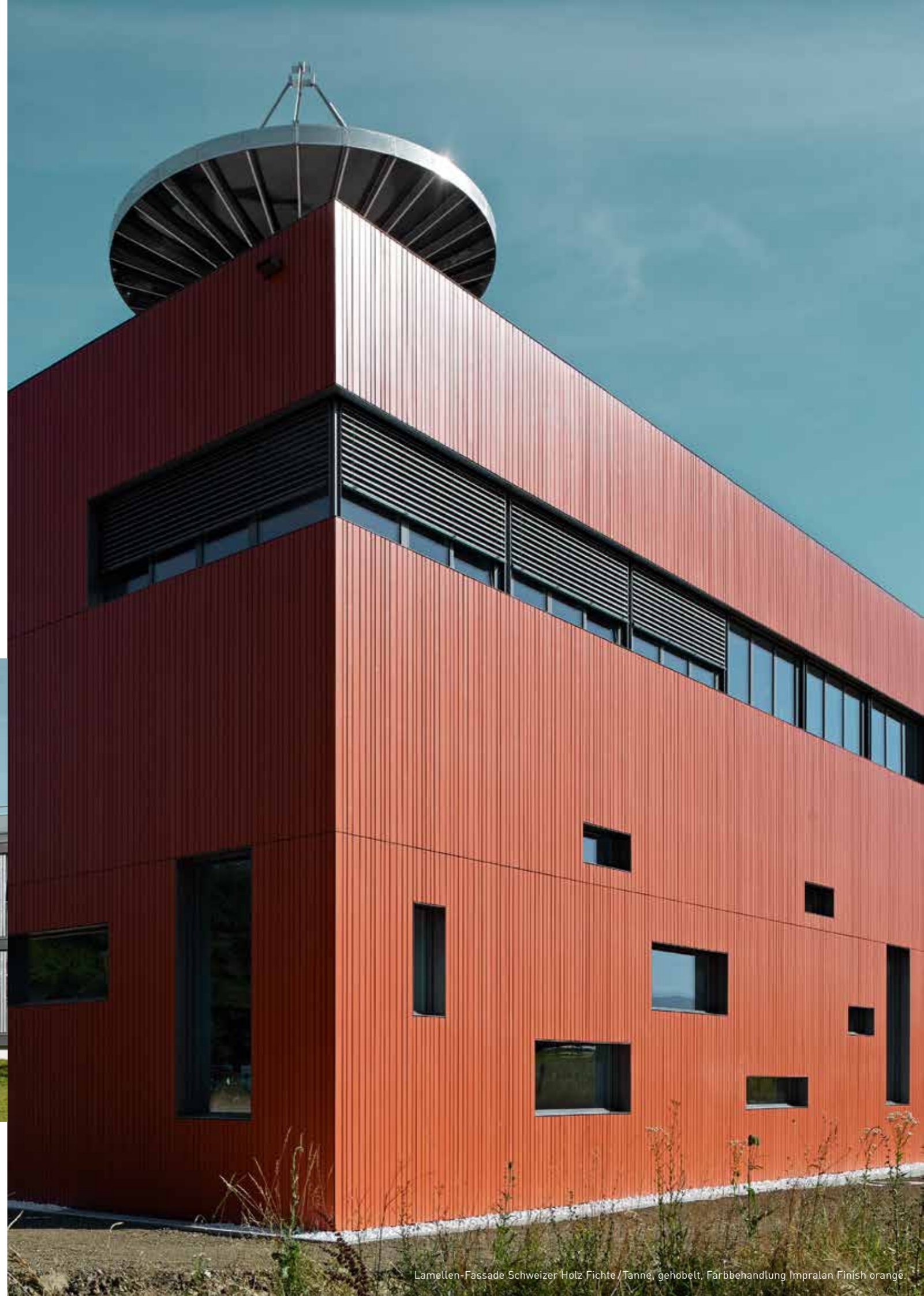
Lamellen-Fassade Fichte, sägeroh, druckimprägniert, Farbbehandlung Impralan Metallic schiefer-anthrazit.
