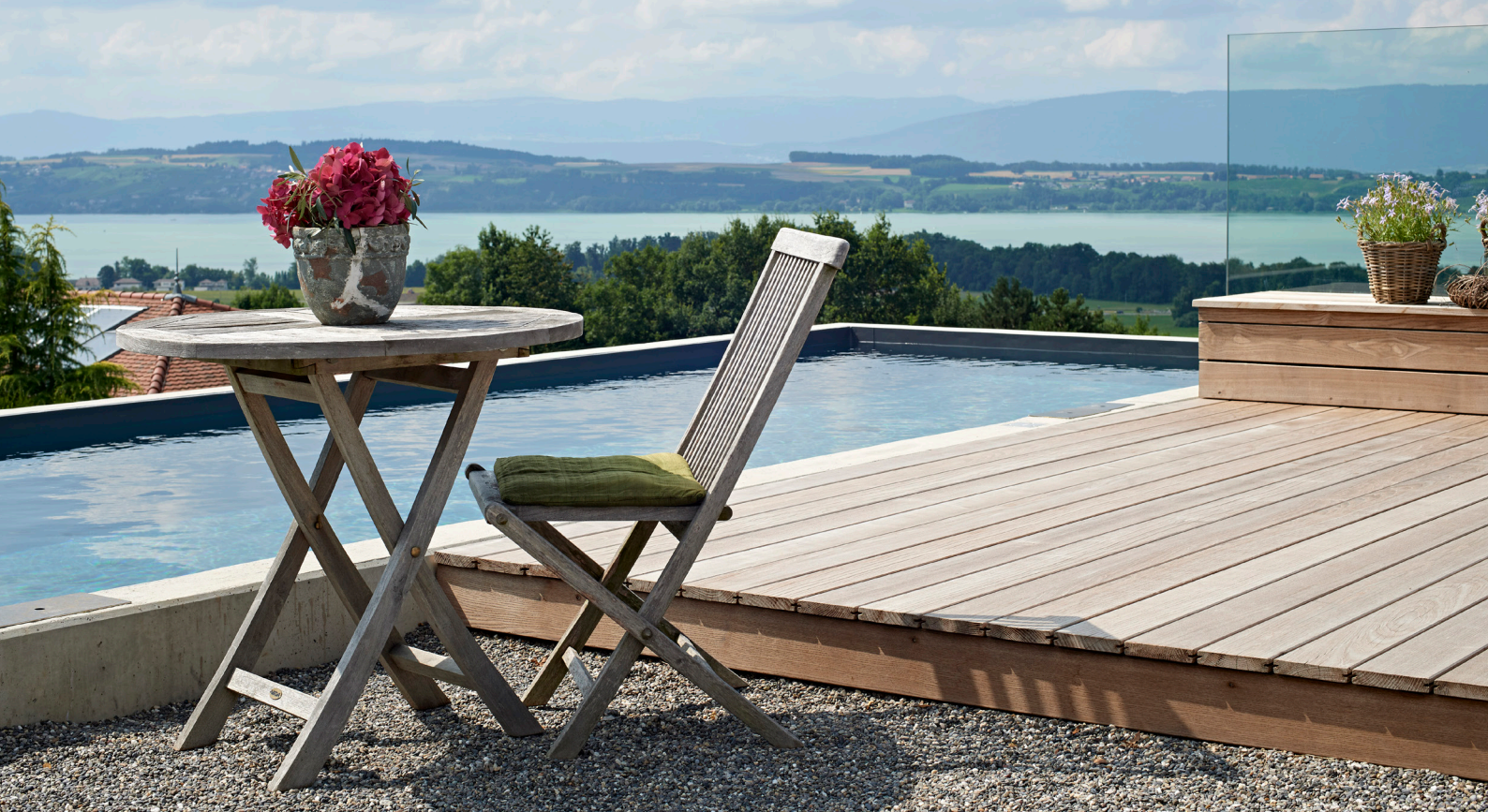
Terrasse in Courgevaux (Terrassenboden Schweizer Thermo Esche, unbehandelt)
